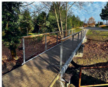
Oprava lávky pro pěší v ulici Chudopleská
