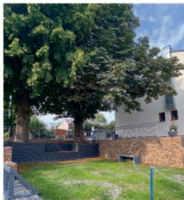
Opěrná zeď u Hostince Na Rozhledně
